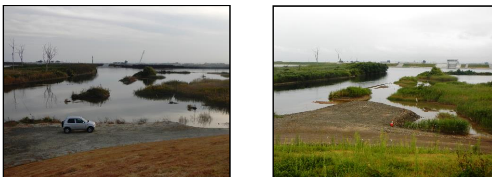
図3. 調査地の景観。左は2015年10月。右は2017年9月。クリークの一部が工事用車両の転回あるいは留置スペースとして埋め立てられている。
