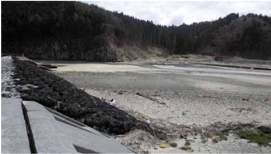
図 8. 津谷川河口右岸の破壊された堤防の裏にできた湿地(2014 年 4 月) 外尾川と平貝川が合流して津谷川に出るところが干潟となった
