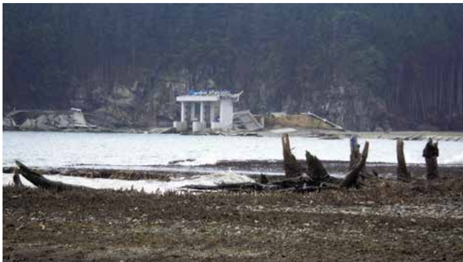
図 6. 震災直後の津谷川河口（2011 年 7 月） 左岸側にあったワンドはヨシ原もろともに消失した
